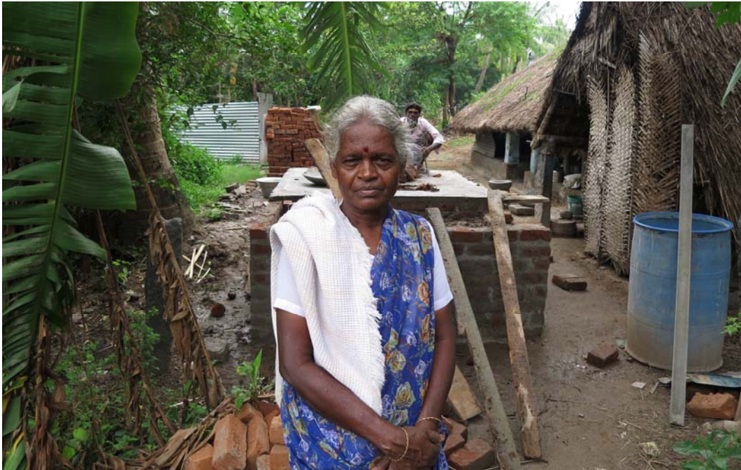
Muthulakshmi, Sumathys Mutter, die zusammen mit ihrem Mann die Bauarbeiten der Komposttoiletten in Boodheri organisiert.
