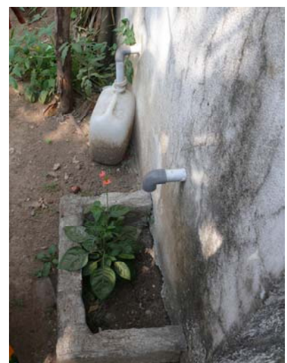
Das Waschwasser wird in einem Sonderbeet gefiltert, der Urin wird für den Garten gesammelt.
